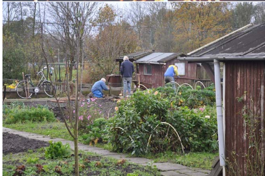
Werkzaamheden aan tegelpad 1.
